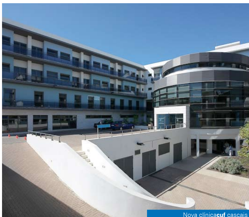
Nova clínica cu f cascais View of the new clínica cu f cascais
